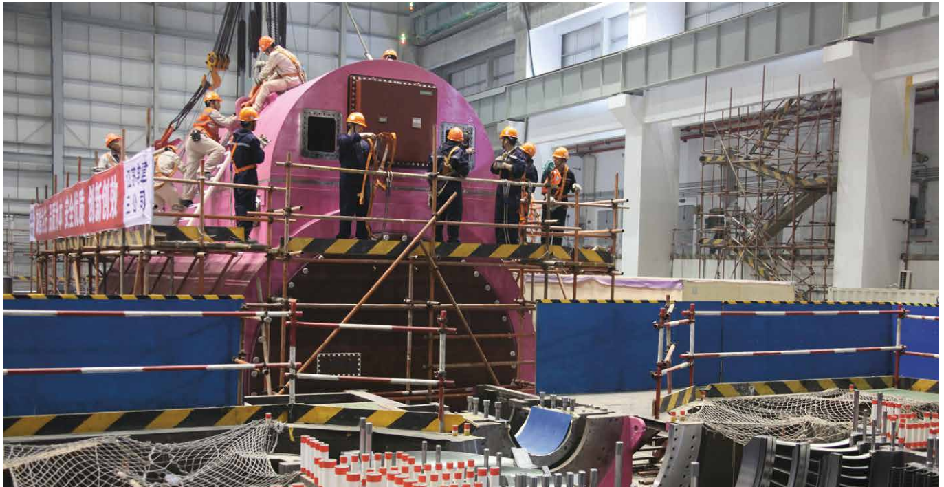
Строительство Тяньваньской АЭС
